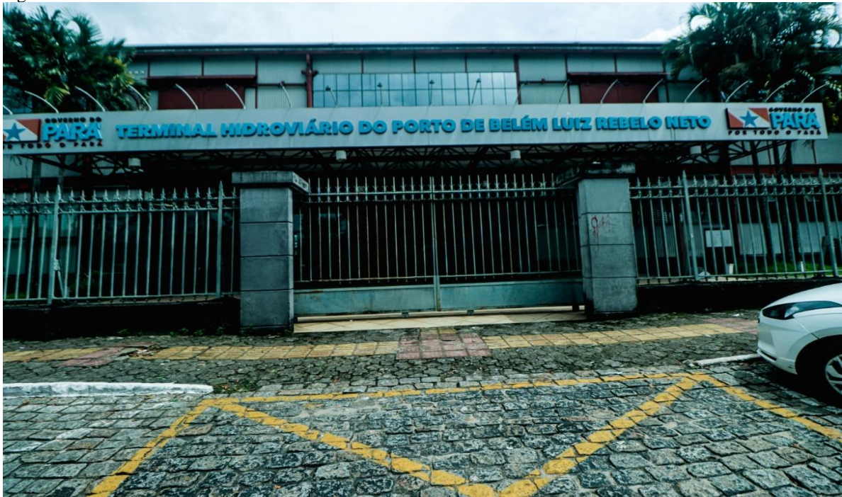
Figura 22: Terminal Hidroviário do Porto de Belém
