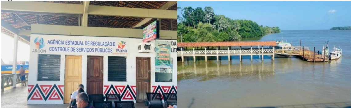
Figura 31: Salas das instituições e estrutura do Terminal Hidroviário de Camará
