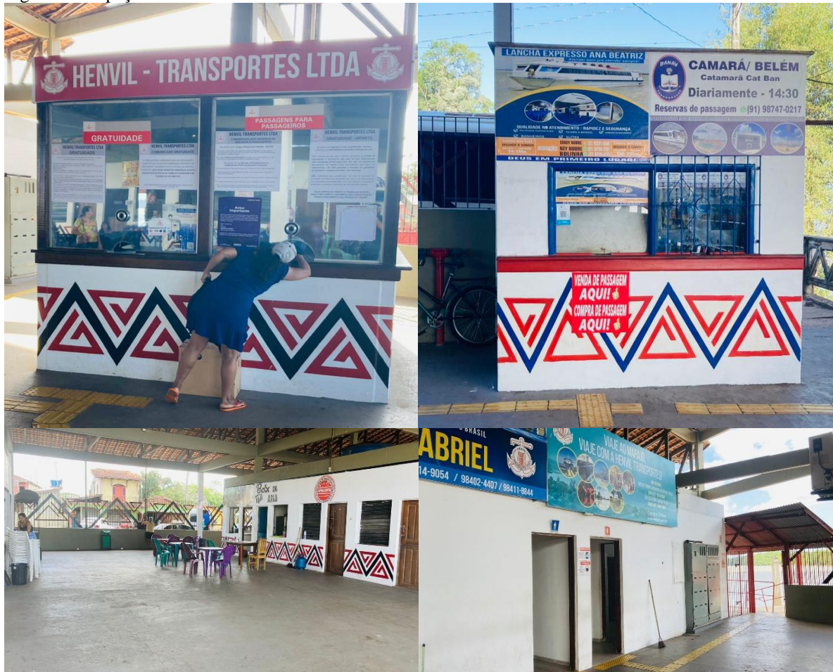
Figura 41: Espaço de acesso comum do Terminal Hidroviário de Camará
